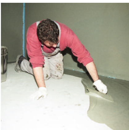
4. ... oder der zementären Sicherheits-Dichtschlämme PCI Seccoral
