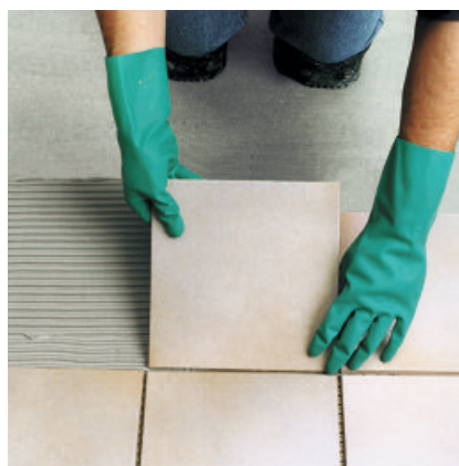
5. der Entkopplungsplatte PCI Polysilent oder den PCI Pecilastic Bahnen überarbeitet werden. Auf dieser Abdichtungs- bzw. Entkopplungsschicht können nach deren Trocknung Fliesen und Platten verlegt werden (siehe Tabelle).
