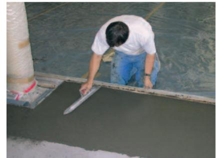
PCI Novoment M1 plus ist ein Schnellestrich-Fertigmörtel und daher eine wirtschaftliche und besonders praktische Lösung für den Einbau von kleineren Flächen und Estrich-Teilflächen, die schnell genutzt werden müssen.
