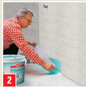
Alle Einbauteile (DICHTUNGSBAND, INNENECKEN, AUSSENECKEN und an Rohrdurchführungen DICHTUNGSMANSCHETTE) mit DUSCHABDICHTUNG fixieren.
