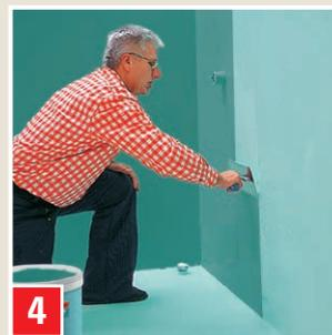
Für den 2. Anstrich beiliegenden Farbbeutel mit Handschuhen öffnen und Farbzusatz in die Masse einrühren. Nach Trocknung der 1. Schicht die eingefärbte 2. Schicht aufbringen. Hier alternativ der Auftrag mit der Glättkelle. Fliesen frühestens nach 18 Stunden kleben.
