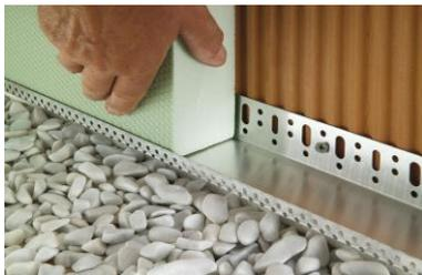
Sockelprofile werden als Abschluss oder Abgrenzung der Fassade bei Wärmedämmverbundsystemen (WDVS) eingesetzt. Sie werden aus Aluminium und für unterschiedliche Dämmstoffstärken hergestellt.
